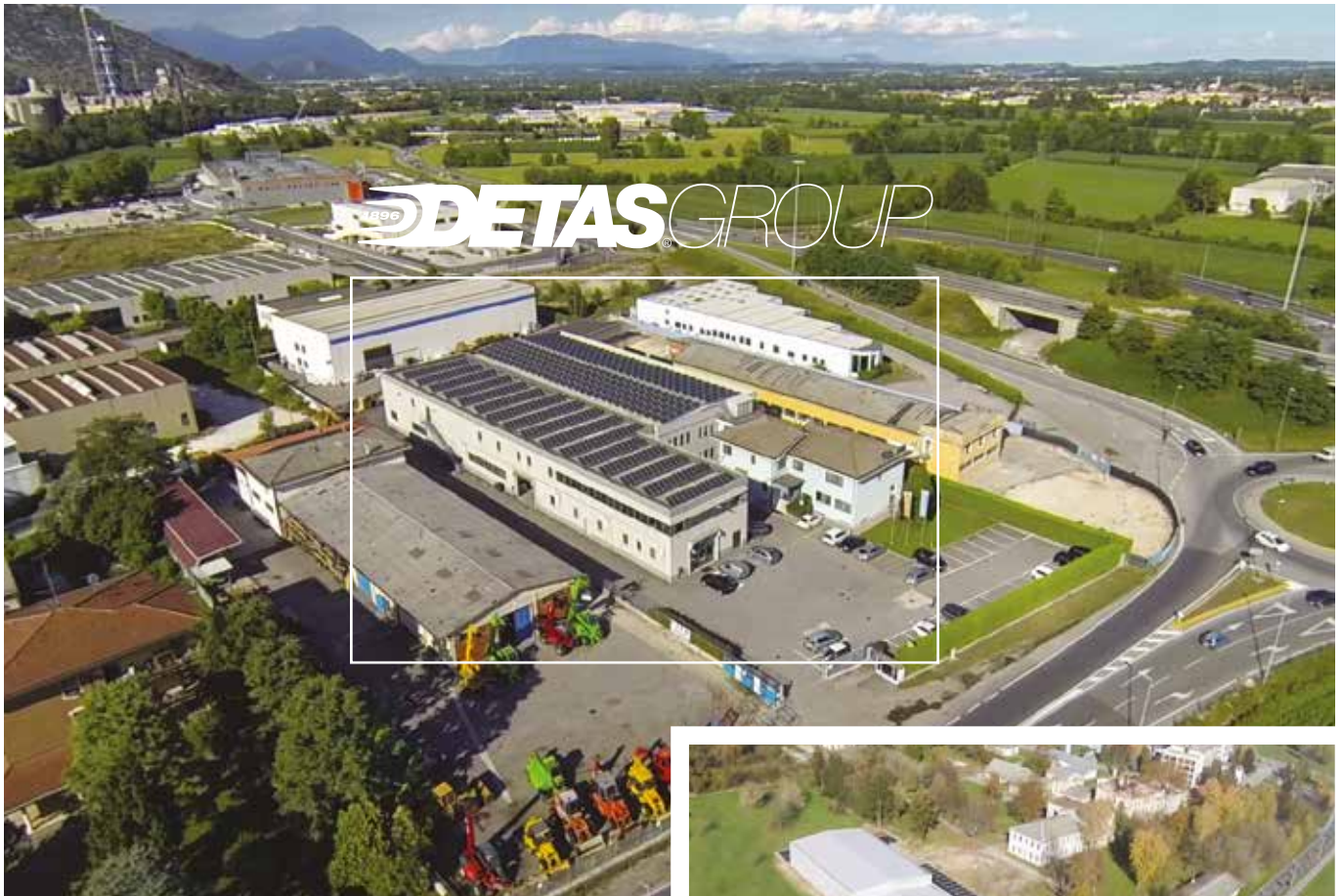
▲ Detas SpA • Rezzato (Brescia) • Italy Detas SpA • Pakrac • Croatia ▶
